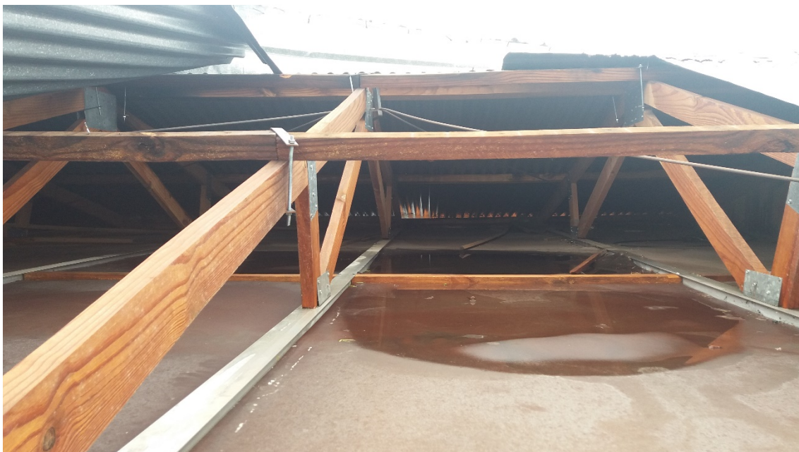
Imagen 3. Conjunto cerchas – correas – chapas en donde se aprecia el apoyo a eje longitudinal de cercha de las correas de madera
