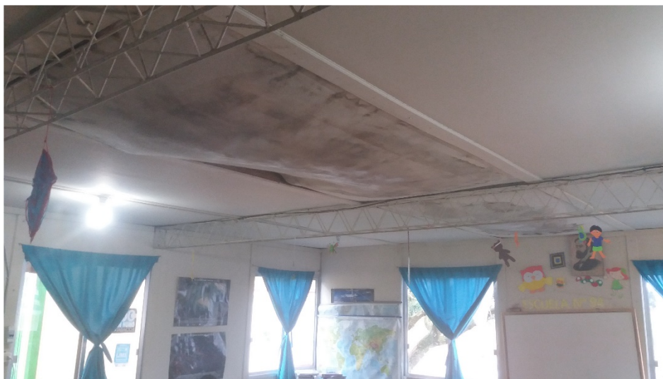
Imagen 5. Situación actual de placa de cielorrasos, debido a filtraciones de agua en cubiertas.
