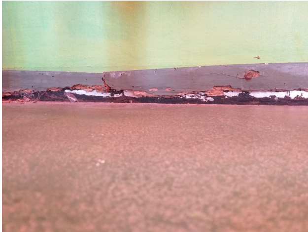
Imagen 8. Zócalo atacado por insectos
